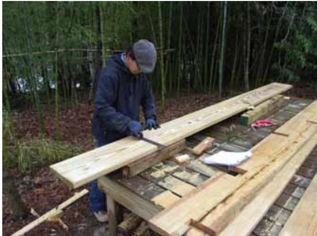
竹の小屋組を支えるフレーム構造は米国で最も手に入れやすい杉の 2\*12 材を用いた。
