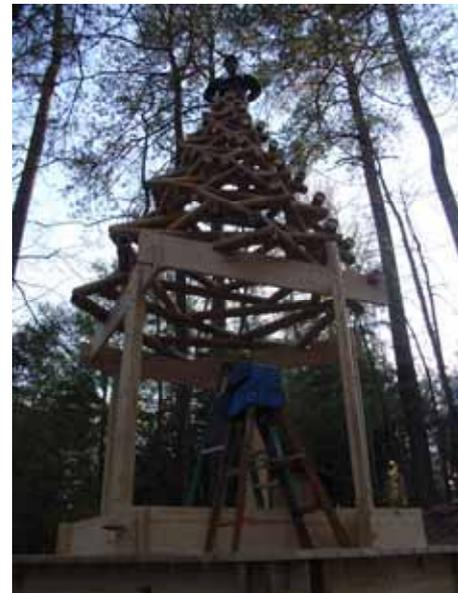
支持フレームと小屋組みは1日で組み立て完成。
